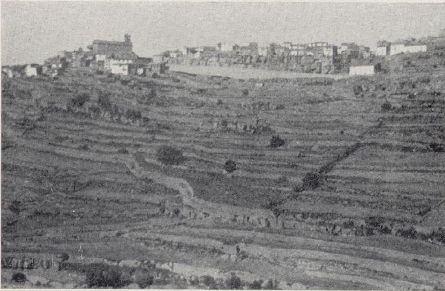
7. — Pueblo de Castellfort. — Areniscas amarillas horizontales.
