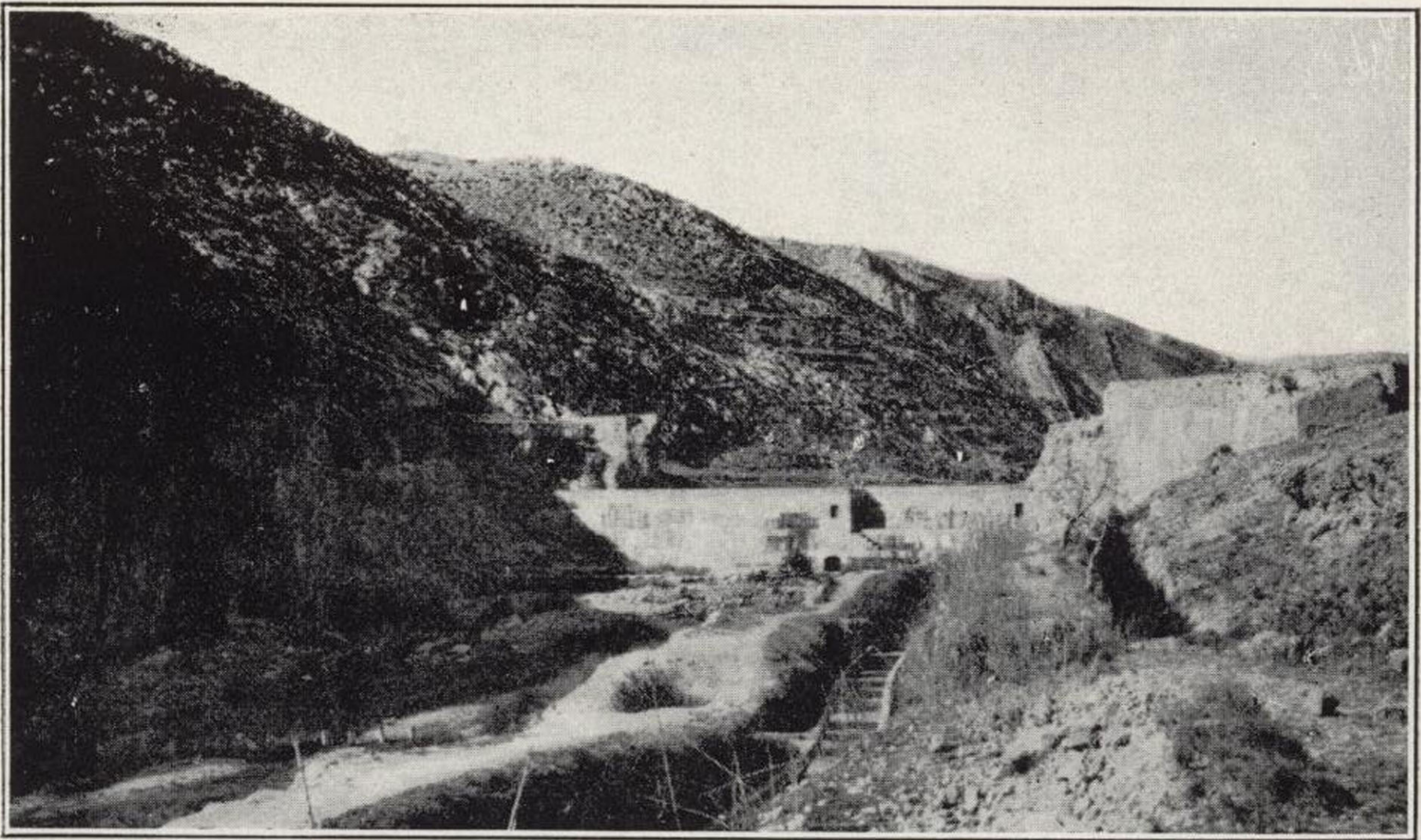
11. Presa en el Vinalopó. Estrecho de Santa Bárbara. Se aprecia a los lados la fábrica de la antigua presa.
